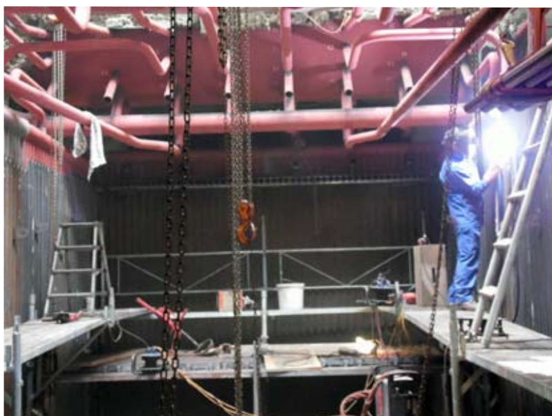
Sanierungsarbeiten an der OL 4
