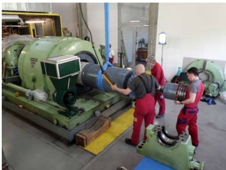
Der revidierte Generatorrotor wird wieder eingebaut
