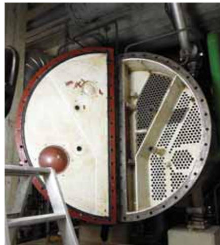
Kondensator der Turbogruppe 1
