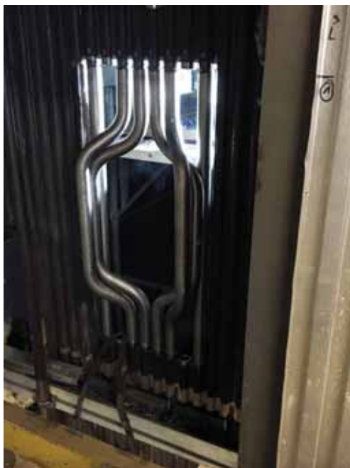
Rohrausbiegungen für eine neue Einstiegstüre der OL 3
