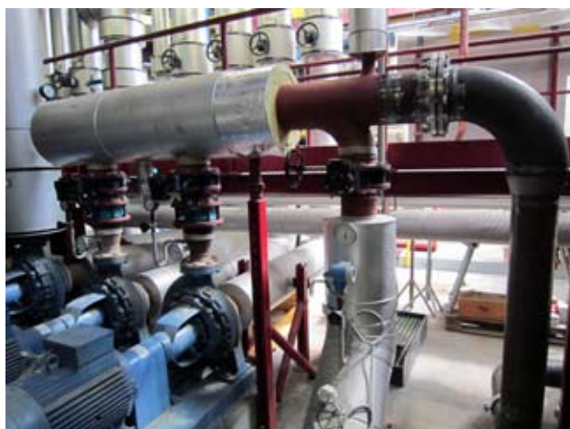
Neue Verbindungsleitung vom Turgi-Ast zum Siggenthaler-Ast
