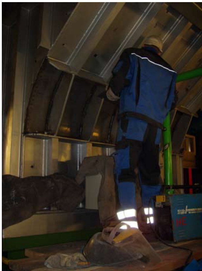
Schweissarbeiten am Einfülltrichter der Ofenlinie 4
