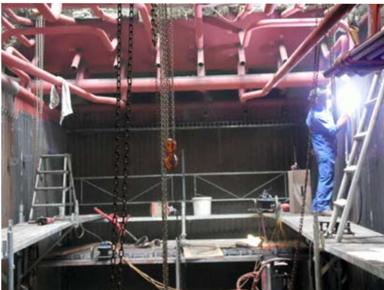
Sanierungsarbeiten an der OL 4
