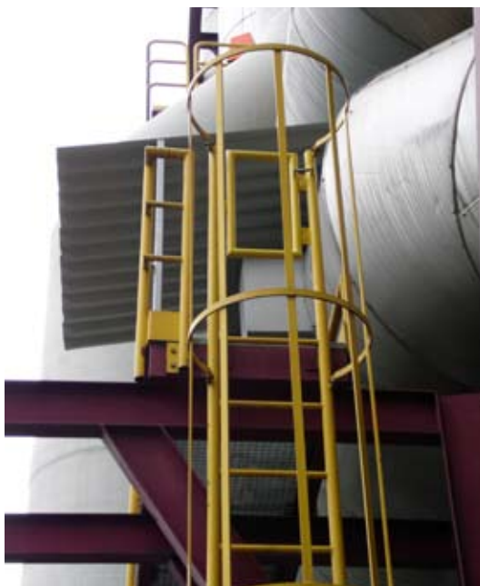
Alle Leiterausstiege wurden mit selbstschliessenden Durchgangssperren nachgerüstet
