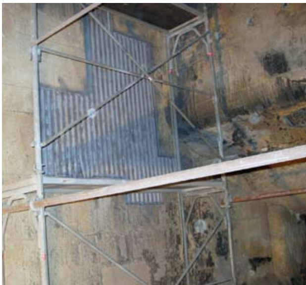
Reparaturen am Mauerwerk der Ofenlinie 4
