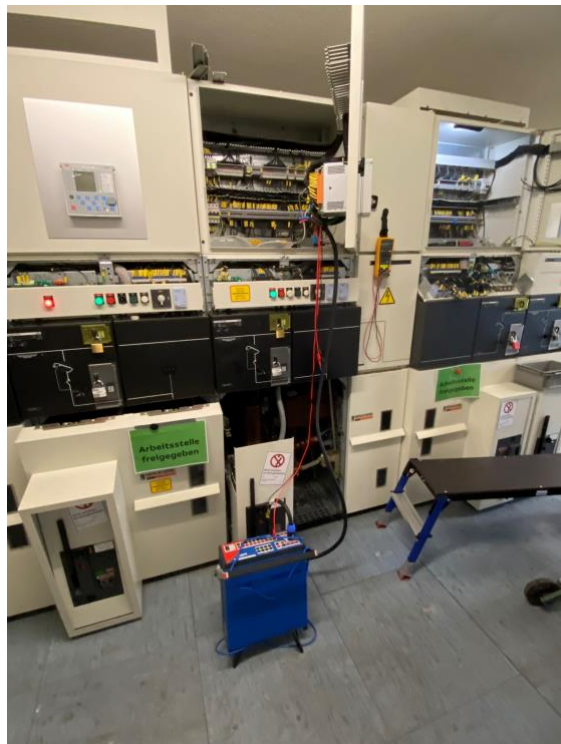
An der Mittelspannungs-Anlage wurden die Steuerung und die Schutzrelais ersetzt.
